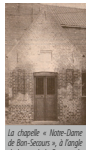
La chapelle « Notre-Dame de Bon-Secours », à l'angle de la rue de la Barre et du Montval Lœux.
